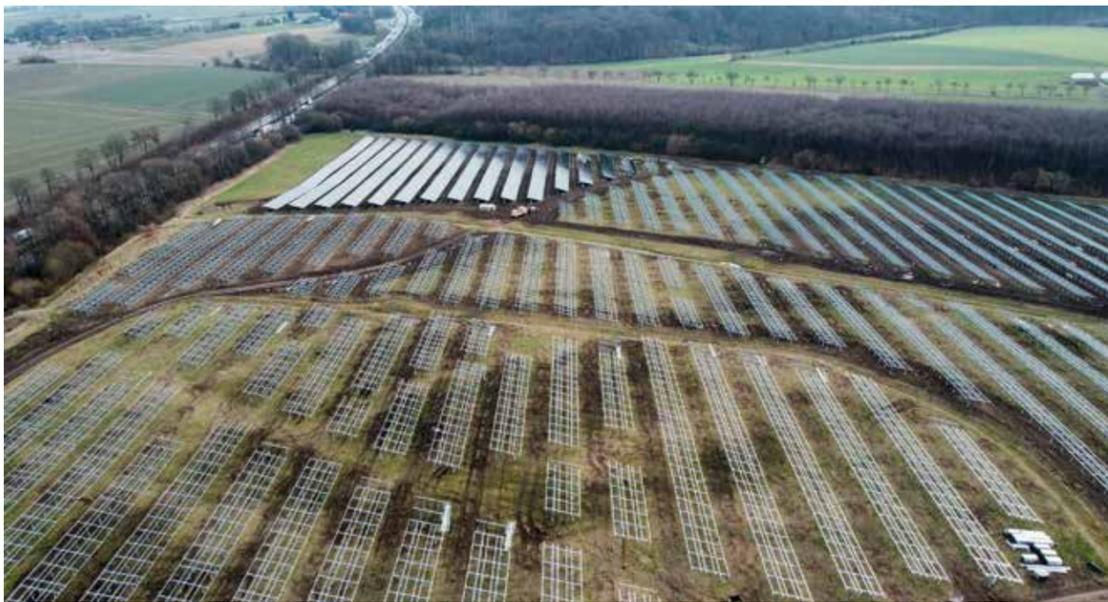
Blick aus der Vogelperspektive auf den neuen Solarpark Fröndenberg mit den schon errichteten Trägerkonstruktionen
